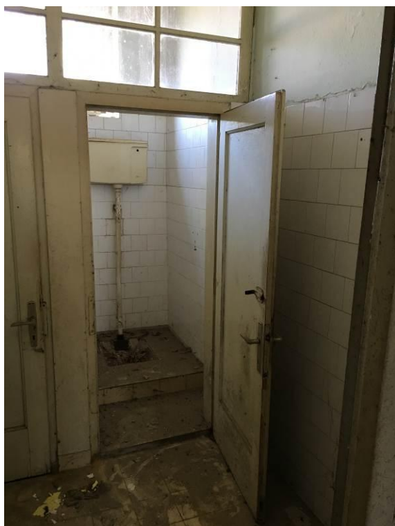
Sanitarije u prizemlju
